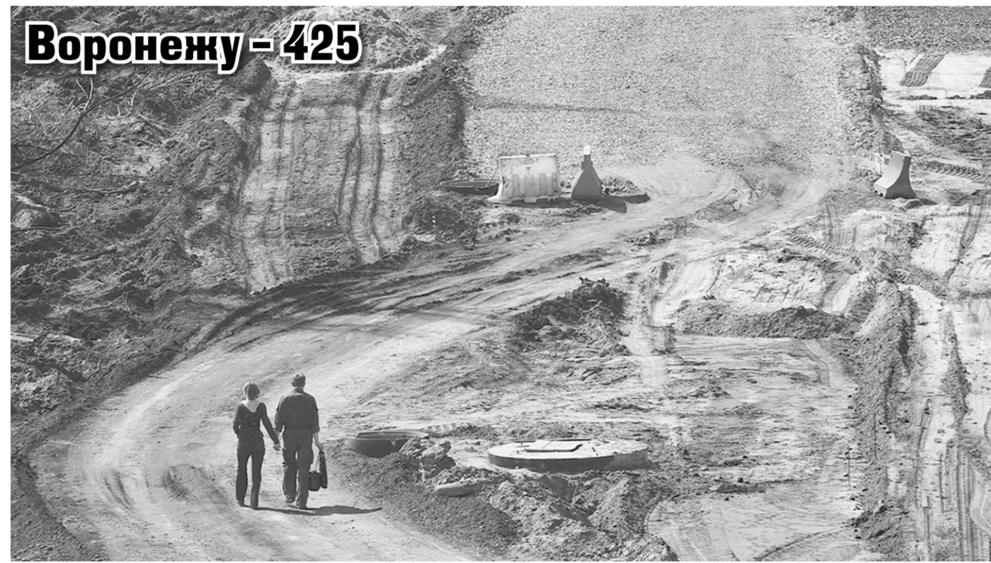
НАБЕРЕЖНАЯ МАССАЛИТИНОВА. ПОКА ИДЁТ СТРОЙКА.
