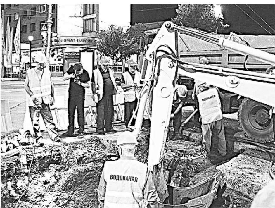
Работы на объектах шли круглые сутки, чтобы минимизировать неудобства для людей.
