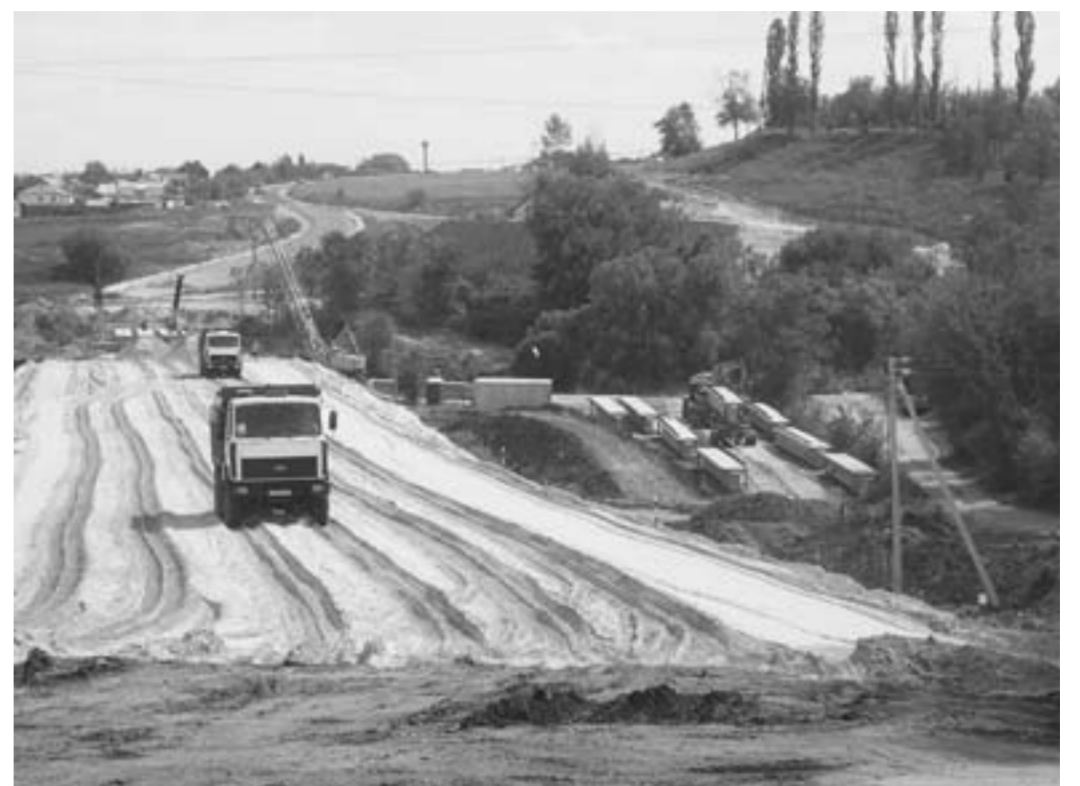
Строительство моста и автодороги по программе «Моногород».
