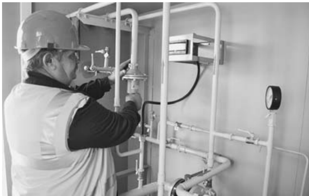
Оборудование работает нормально, безопасность гарантирована.
