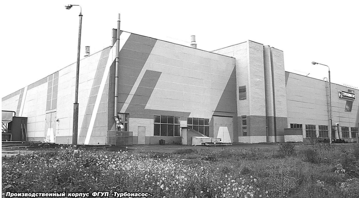
Производственный корпус ФГУП «Турбонасос».
