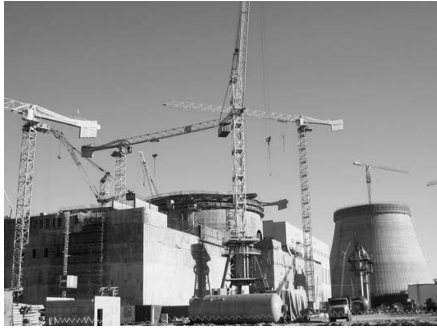
На площадке сооружения НВО АЭС-2.
