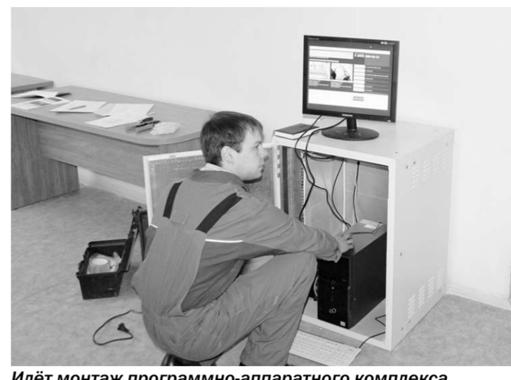
Идёт монтаж программно-аппаратного комплекса.
