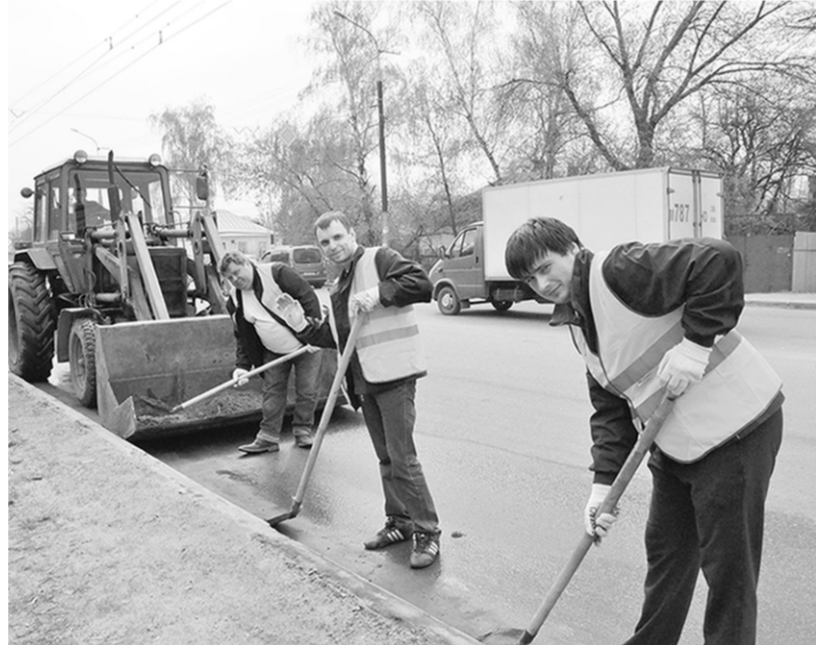
Бригада комбината благоустройства за работой.
