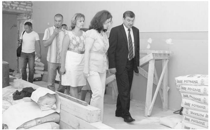
Сергей Колюх осматривает ремонтируемые помещения.
