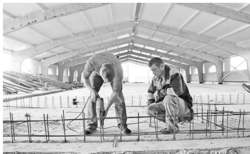
В главном корпусе идут монтажно-бетонные работы.
