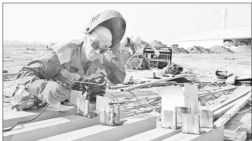
Идёт сварка очередных конструкций.
