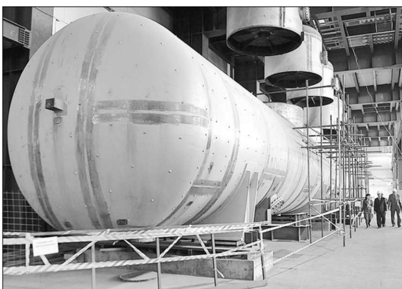
Масштабы строительства Нововоронежской АЭС-2 впечатляют.
