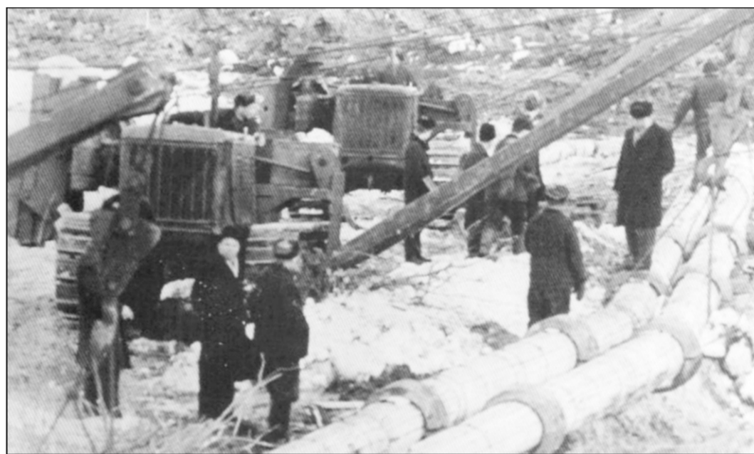
Строительство 2-го дюзера на улице Коммунаров.
