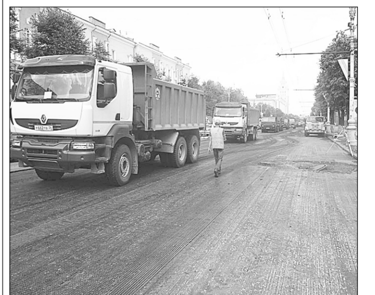
Самосвалы RENAULT ООО «СпецДорСервис» на ремонте проезжей части проспекта Революции.
