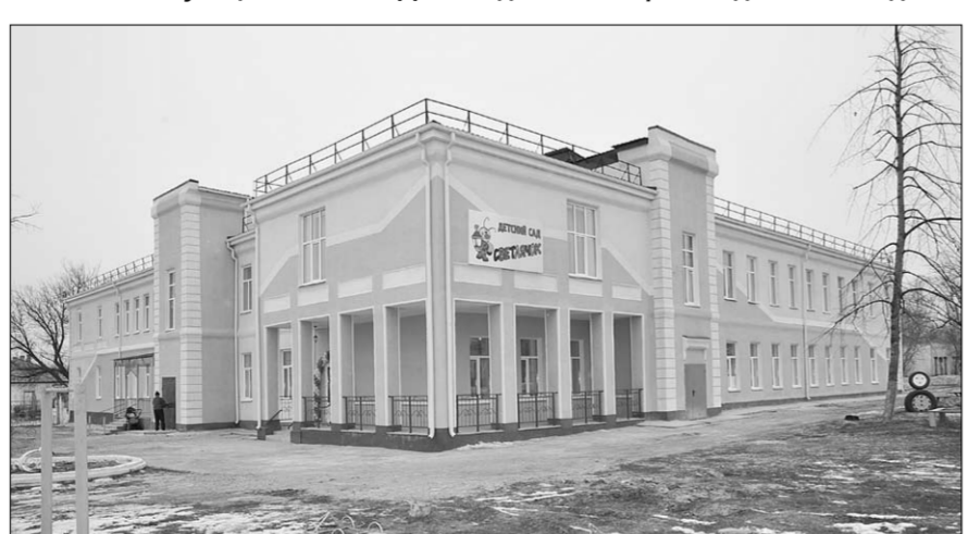
Развитие «Светлячка» продолжается. В скором времени начнётся благоустройство прилегающей территории. Здесь появятся небольшой стадион и игровые зоны.
