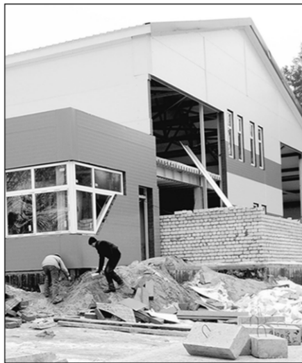
Возведение ФОКа в посёлке Слобода Бобровского района.
