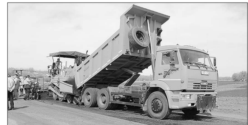
Укладка асфальтобетона на участке дороги «Воронеж-Луганск»-Подгоренский.
