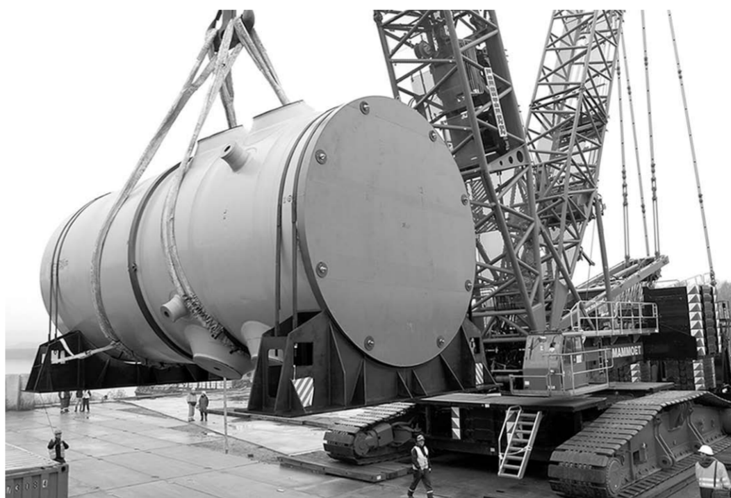
Корпус реактора ВВЭР-1200 для второго энергоблока доставлен на стройку водным путём.
