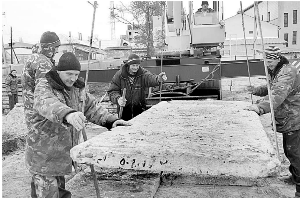
Монтажники ООО «Арт-строй» закладывают фундамент очередного дома.
