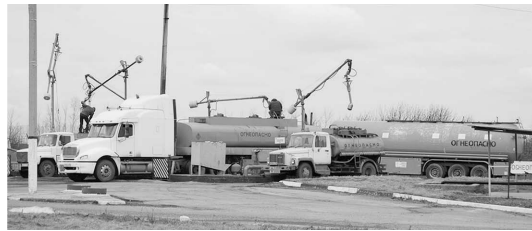
Автоматическая станция дизтоплива.
