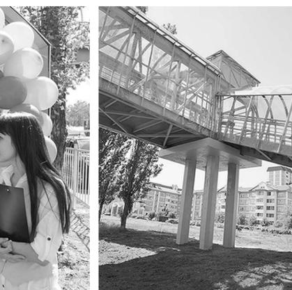
составила 49,5 миллиона рублей. Длина перехода на 217-м километре автодороги Р-298 «Курск-Воронеж» — 75,29 м, ширина — четыре метра при затратах в 19,9 миллиона рублей. Для исключения попадания внутрь них атмосферных осадков оба перехода закрытого типа. Для подъёма
