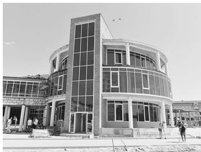
Во Дворце культуры уже идут отделочные работы.
