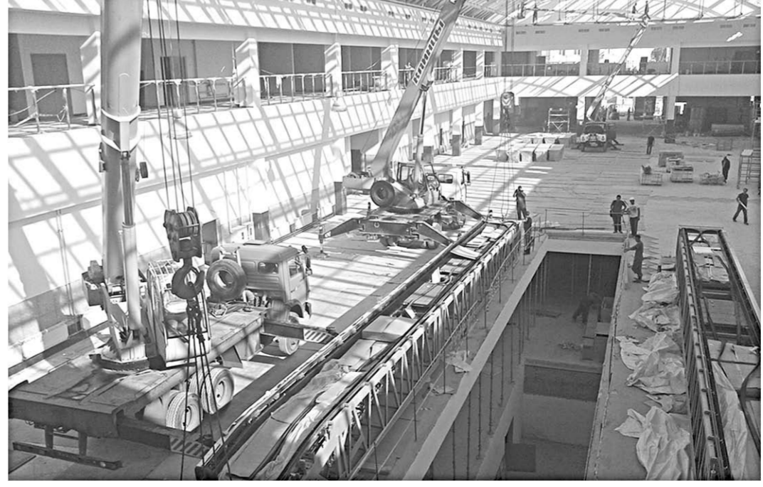
Монтаж пассажирского конвейера на Центральном рынке.
