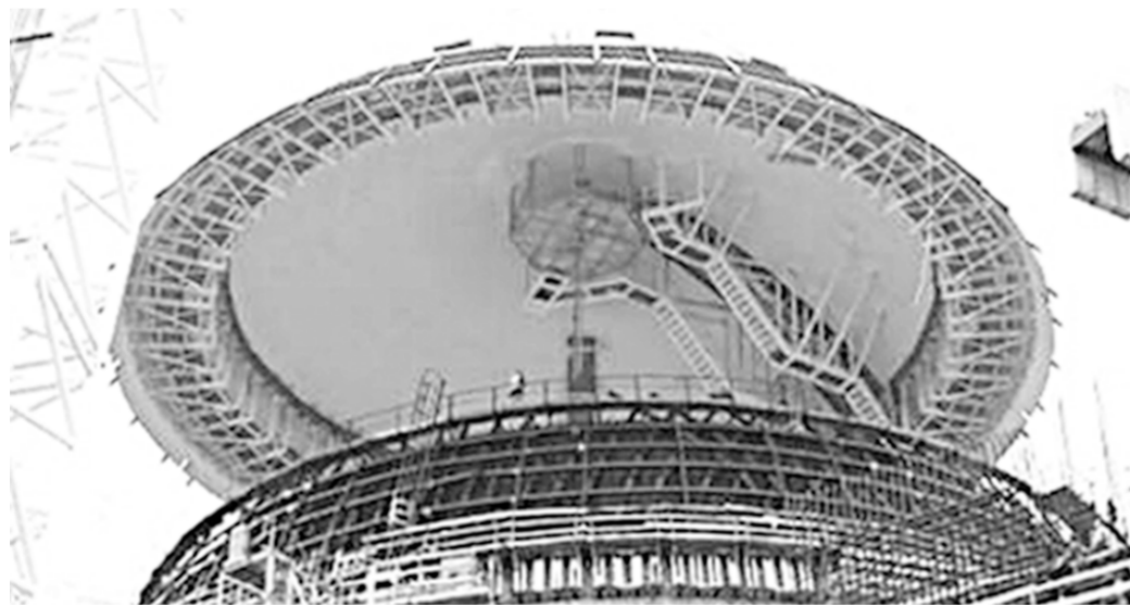
Идёт монтаж купола энергоблока №2.
