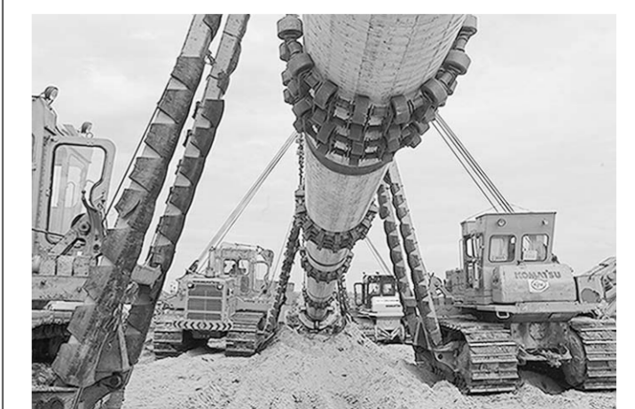
Километр за километром прирастает нитка газопровода.
