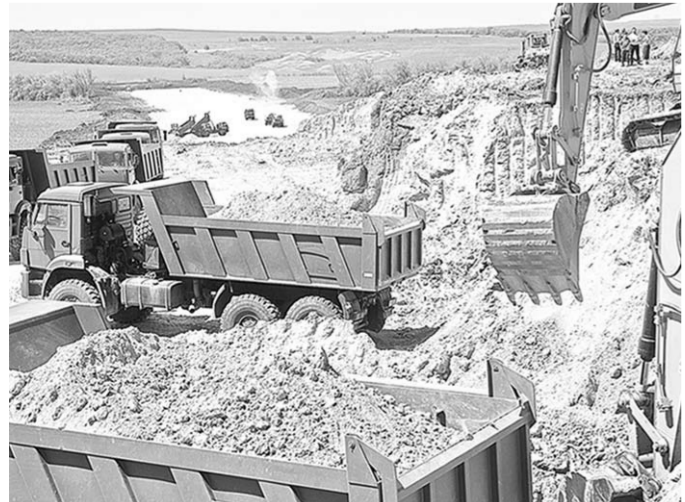
Техника на выемке грунта работает как хорошо отлаженные часы.
