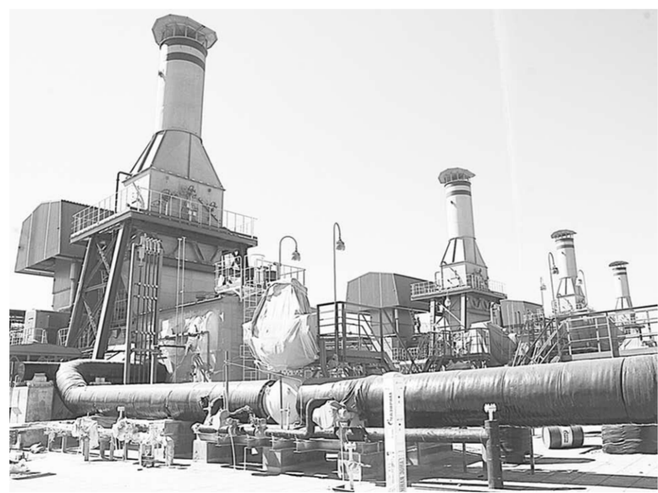
Компрессорная станция «Писаревка» уже почти готова к сдаче.
