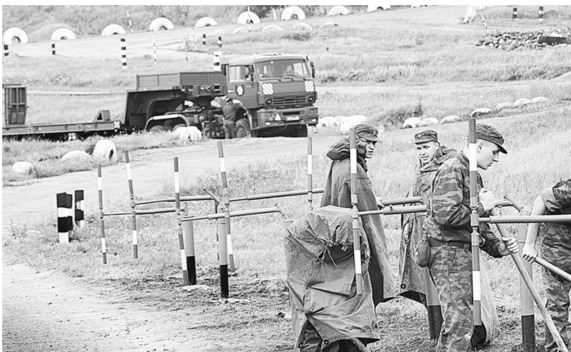
Идёт оборудование одной из трасс автодрома.
