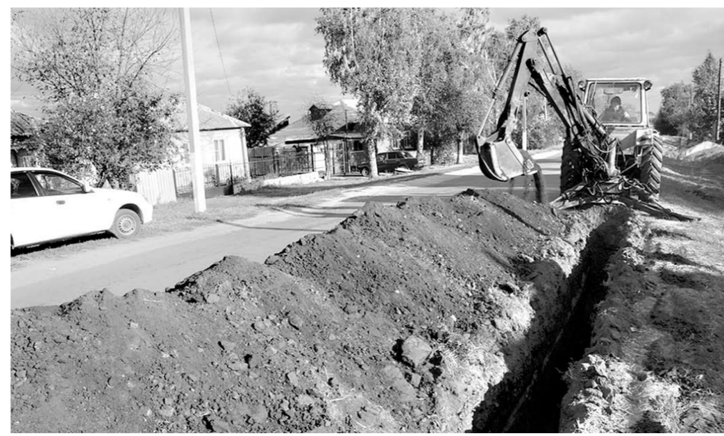
Идёт прокладка нового водопровода.
