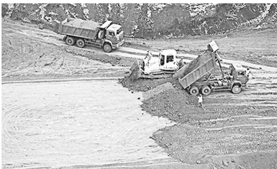
Строительство железнодорожного полотна идёт полным ходом.
