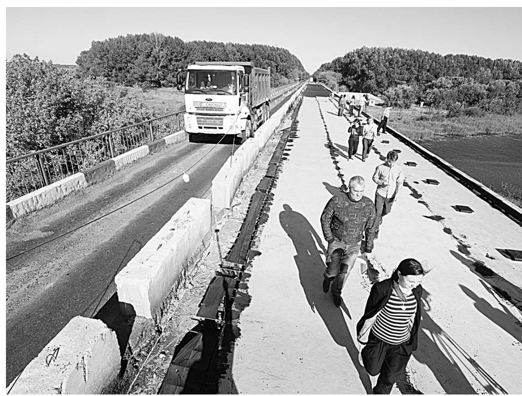
Мост через Битюг ремонтируют с использованием инновационных материалов.
