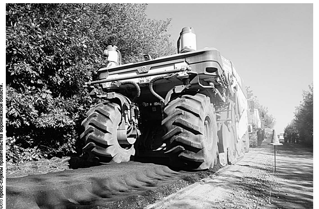
Изношенное дорожное покрытие проходит через ресайклер и получает вторую жизнь.
