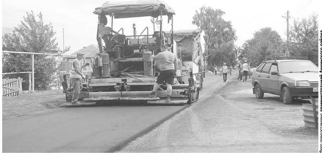
Вот так в Аннинском районе укладывают выравнивающий слой асфальта на сельских улицах.
