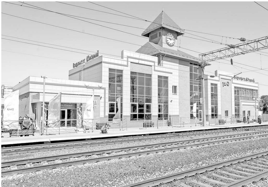
Так выглядит здание нового вокзала.
