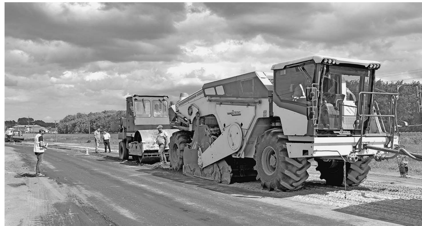
Рабочие восстанавливают дорогу методом холодного ресайклинга.
