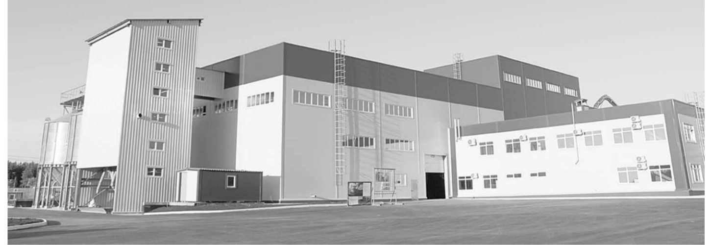
Крахмалопаточный завод в Рамоновском районе. Общая стоимость проекта оценивается в сумму около 700 миллионов рублей. В результате дополнительно создано 152 рабочих места. Завод на 90 процентов укомплектован высокотехнологичным отечественным оборудованием. Планируемый годовой объём переработки кукурузы – 50 000 тонн.
