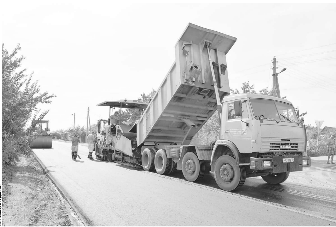
В селе Осиковка Кантемировского района идёт восстановление дорог, разрушенных при строительстве железнодорожной линии в обход Украины.
