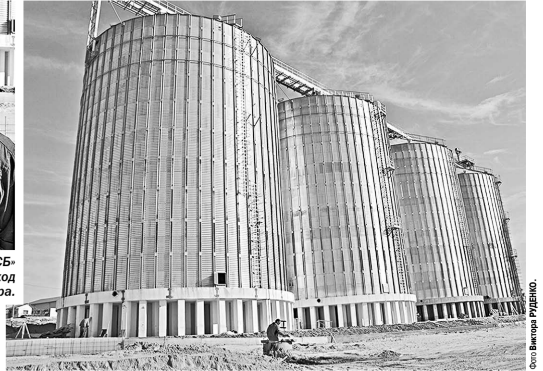
Новый элеватор в Кантемировском районе построен по современным технологиям.
