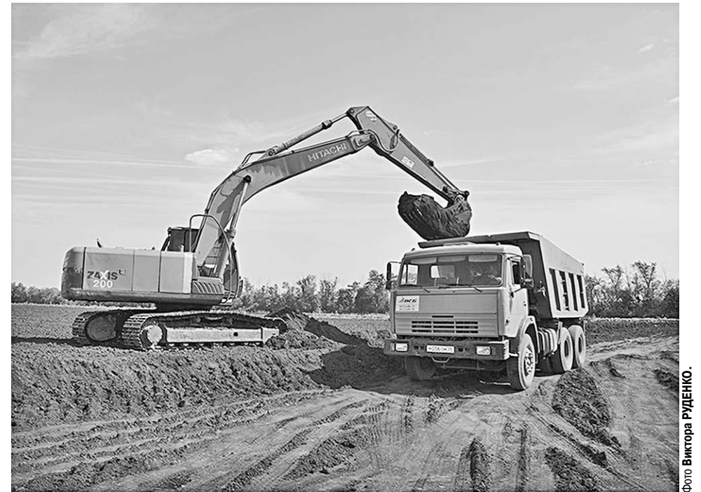
С площадки будущего комплекса бережно снимают чернозём.
