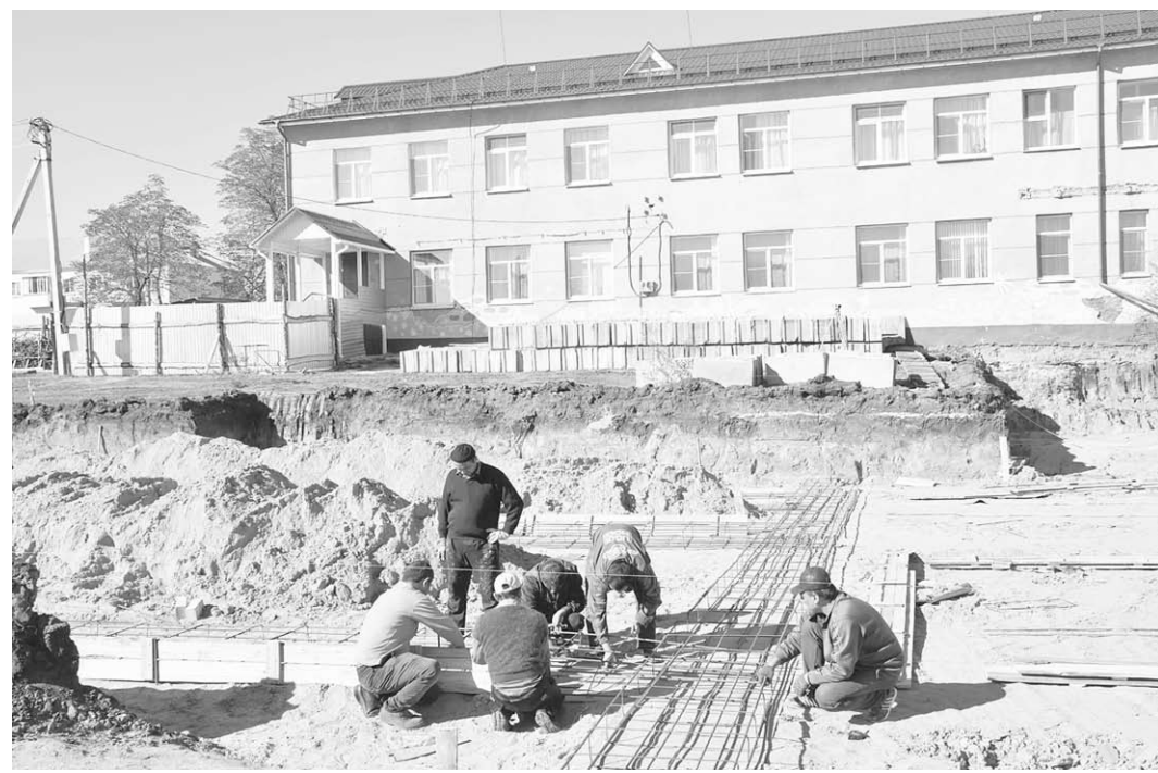
На новой стройплощадке во дворе «Родничка» уже готовится фундамент.
