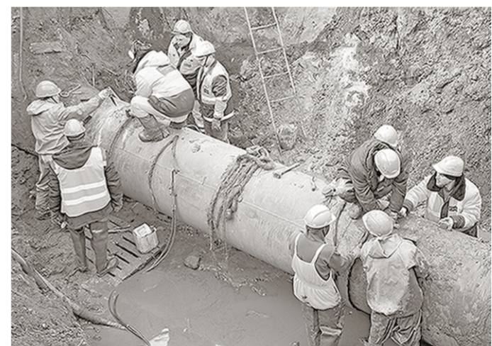
Сварщики устраняют прорыв трубопровода.
