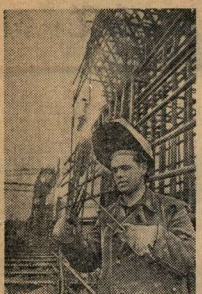
На снимке: один из лучших электростроителей правобережного арматурно-сварочного завода депутат Жигулевского городского Совета депутат трудящихся комсомолец И. Суханов на сварке арматуры для здания ГЭС. Он выполняет норму на 200—250 процентов. Фото Н. Финникова (ТАСС).
