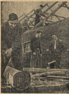
На снимке: строительство свинофермы. На переднем плане — плотник Николай Жабев. Фото А. Галкина.
