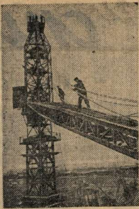
На строительстве Куйбышевской гидроэлектростанции устанавливаются теле-скопические краны высотой 67 метров с вылетом стрелы 40 метров для монтажа гидротурбин и гидрогенераторов. На снимке: монтаж одного из теле-скопических кранов. Фото Н. Финникова (ТАСС).
