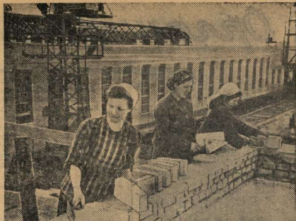
С первых дней на строительстве завода железобетонных конструкций треста № 25 работает бригада каменщиц Нины Кривошевой. Молодые работницы систематически перевыполняют нормы дневных заданий.
