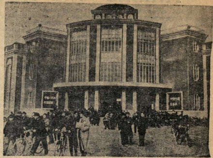
Китайская Народная Республика. В прошлом году на Аньшаньском металлургическом комбинате построен новый клуб. Он стал сейчас центром культурно-массовой работы среди рабочих и служащих предприятия. На первом: внешний вид клуба. Фото агентава Сянхуа.
