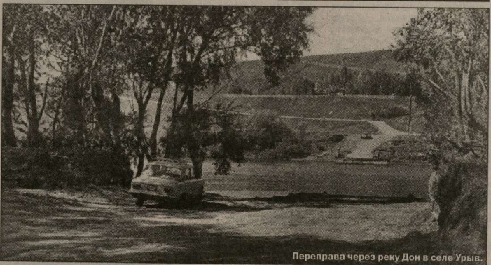
Переправа через реку Дон в селе Урьв.
