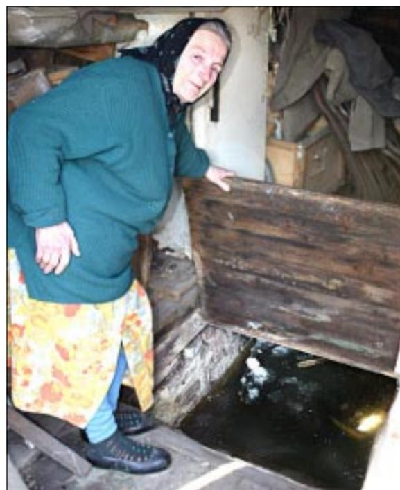
**...в подвале стоит вода на уровне около 30 см. Тепловая камера, расположенная в палисаднике, также залита водой по причине высокого уровня грунтовых вод».**
