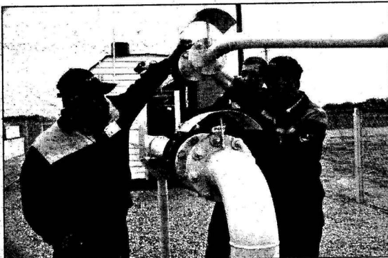
Газопровод в селе Замостье готов к эксплуатации.
