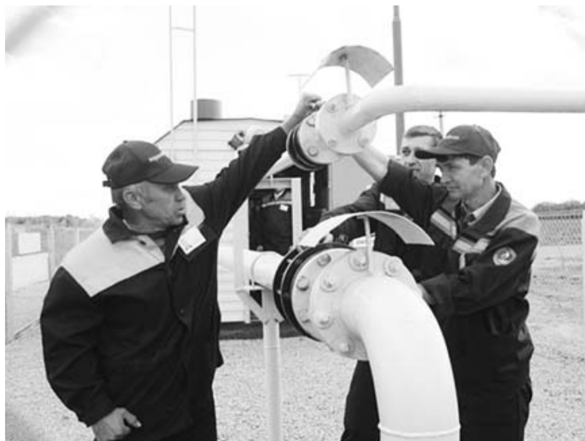
Газопровод в с. Замостье Петропавловского района.
