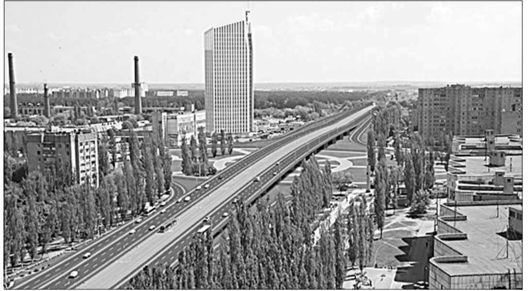
Транспортная двухуровневая развязка на пересечении Ленинского проспекта и ул. Остужева.
