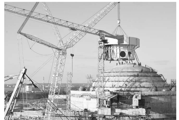
Идёт монтаж купольной части системы безопасности энергоблока №1.
