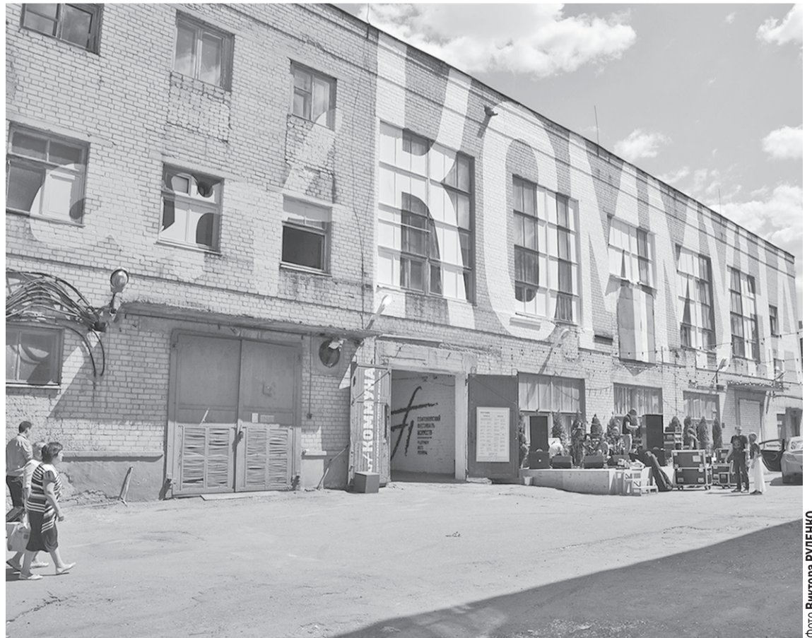
Здание бывшей типографии в дни фестиваля не однажды становилось одной из главных его площадок, где проходили выставки и творческие встречи с писателями, переводчиками, исследователями наследия Платонова. Июнь 2015 года.
